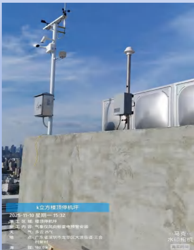
深圳市龙华区K立方楼顶停机坪项目
